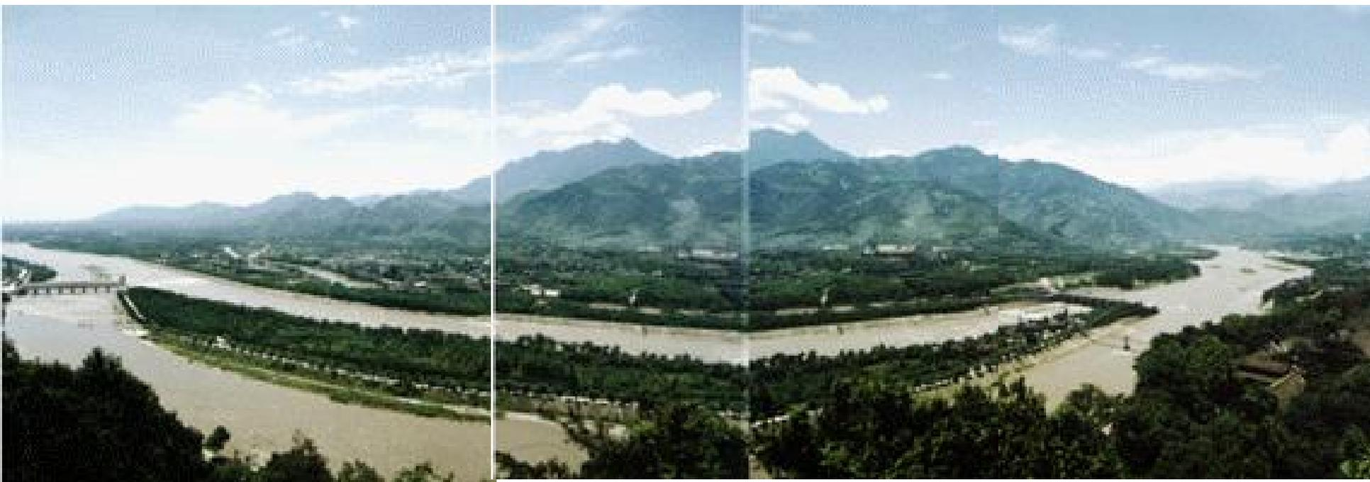
都江堰渠首工程主要有：鱼嘴分水堤、飞沙堰溢洪道、宝瓶口进水口
