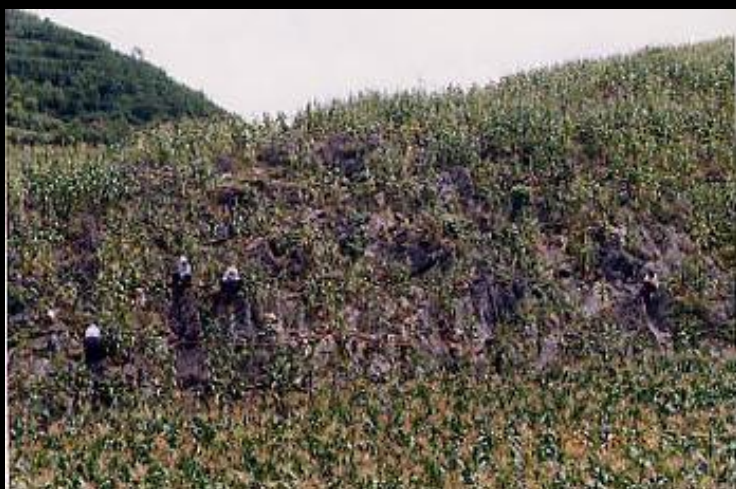
隧道 进口 左侧 岩层 及构 造统 计
