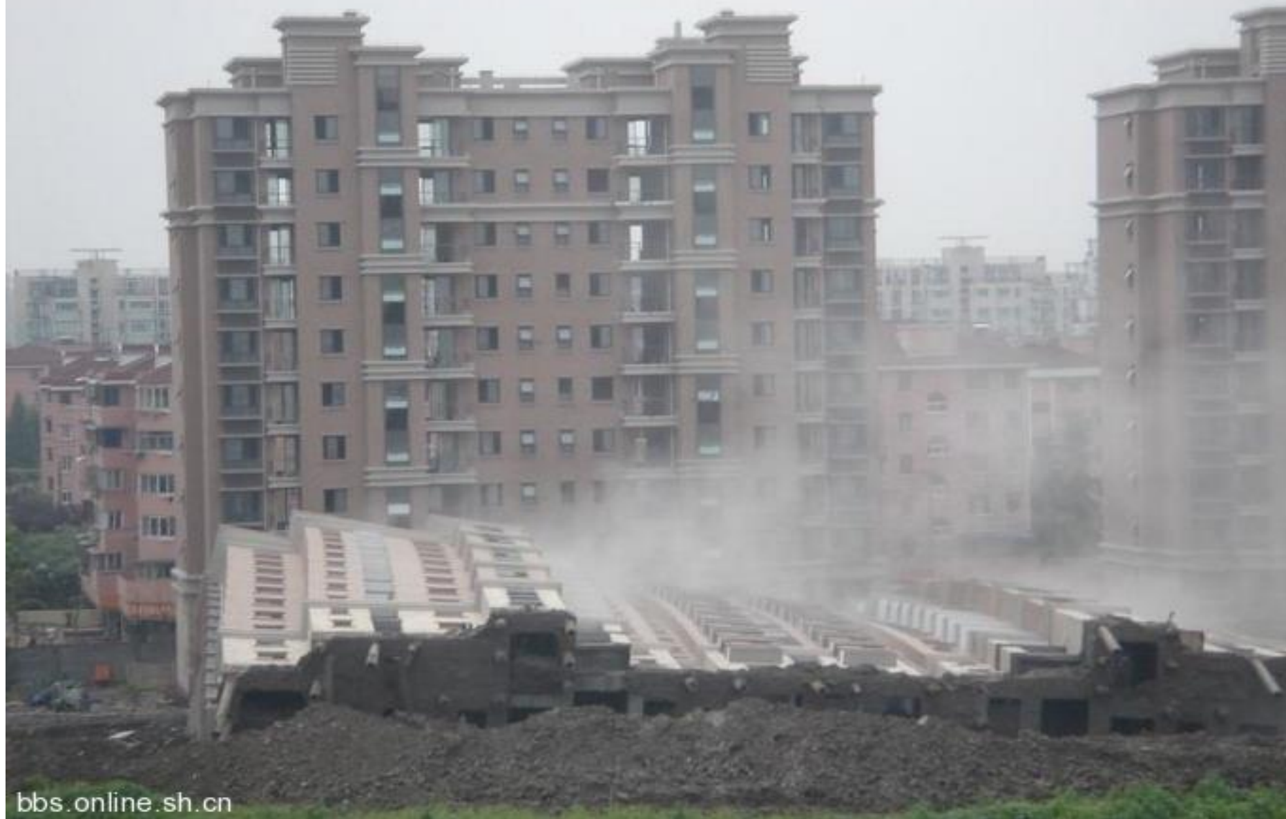
图1 13层楼房（7号楼）向南整体倾倒事故
