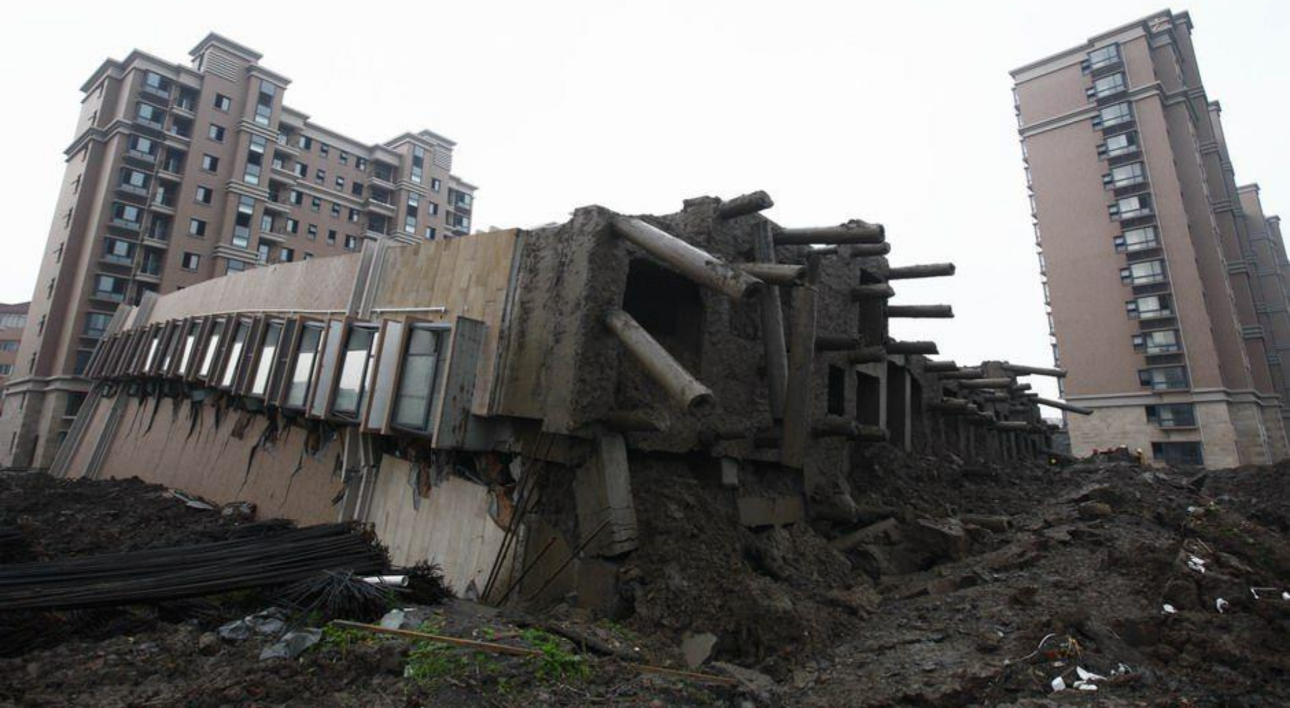
图5 北面的断桩长度长，南面的断桩长度短。
