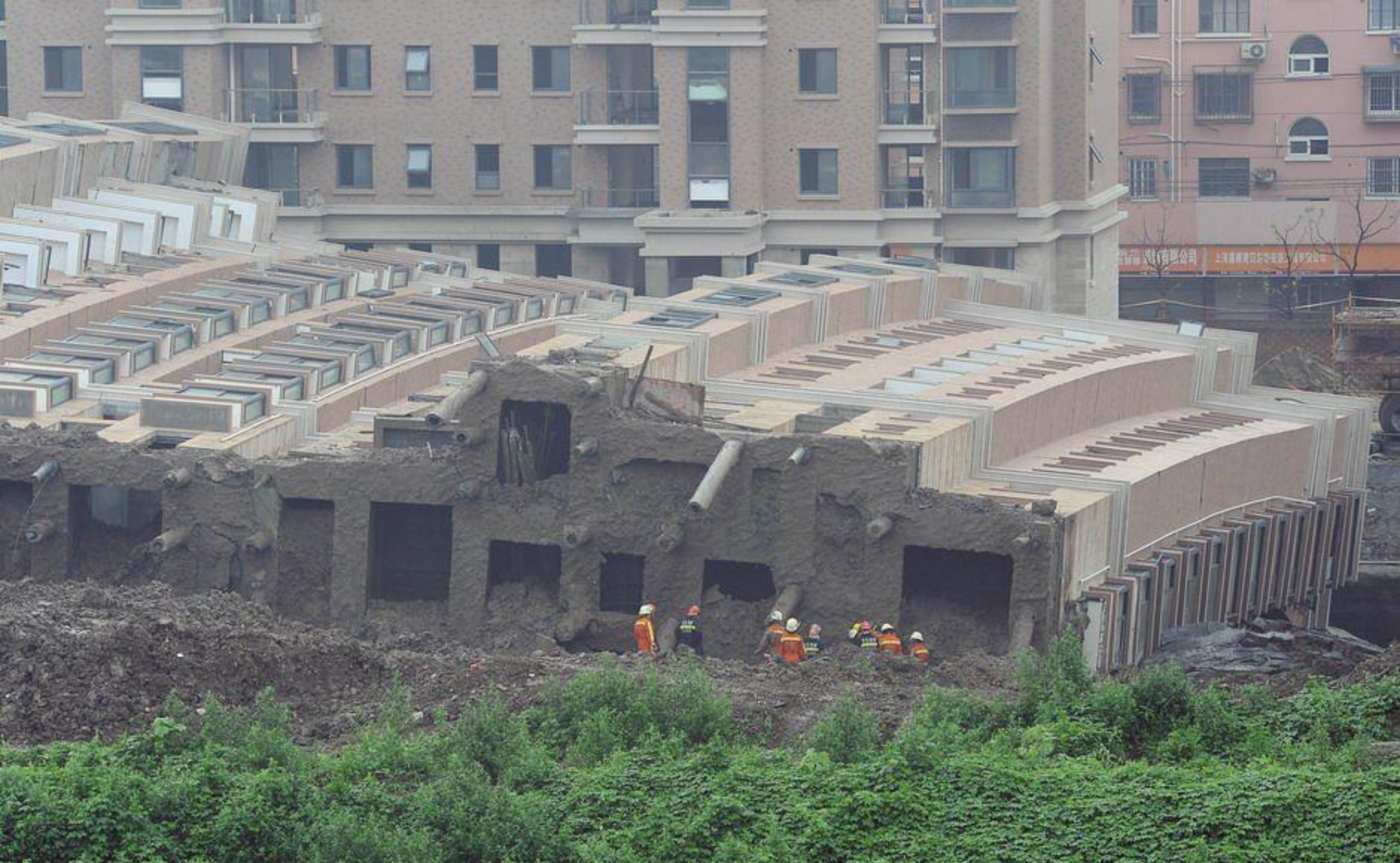
图4 整体倾倒的楼房(十字条形基础)
