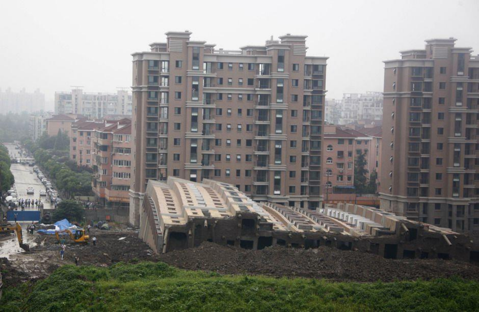
图2 整体倾倒的楼房（7号楼）
