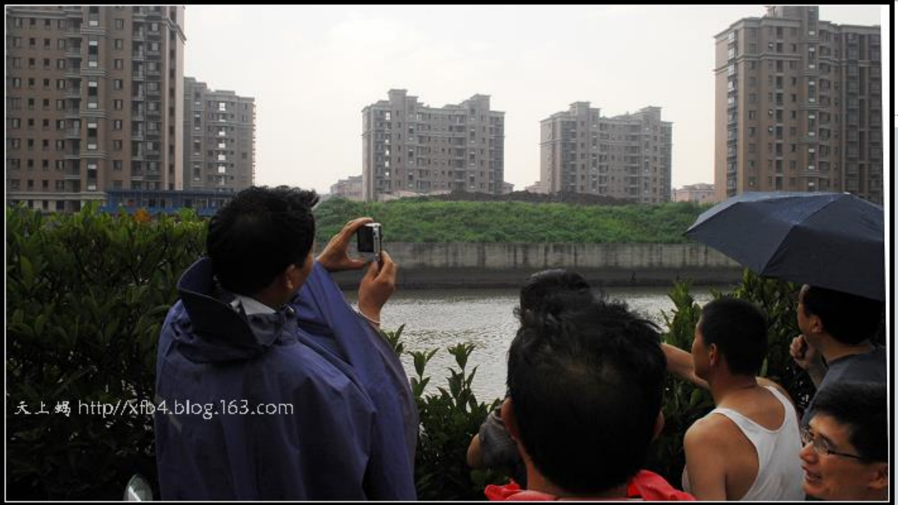
图3 十多米宽的倒塌楼房几乎被堆土全部遮住
