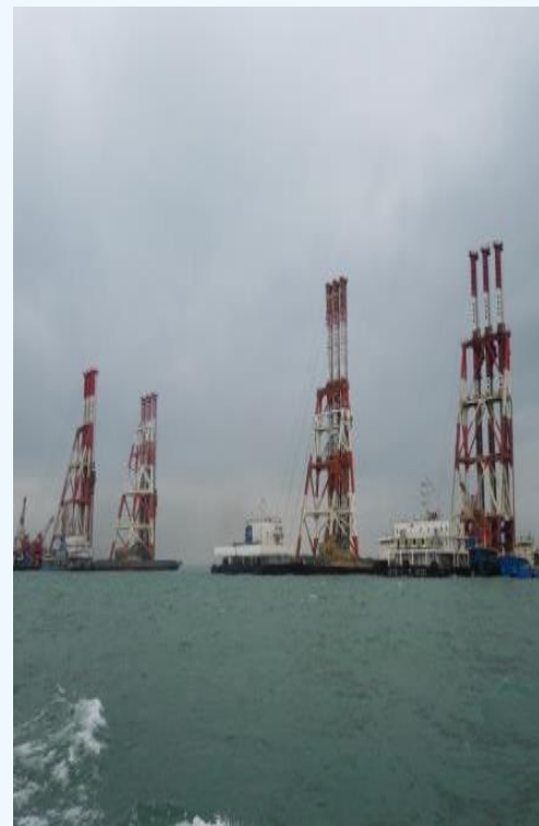
挤密砂桩工艺试验
