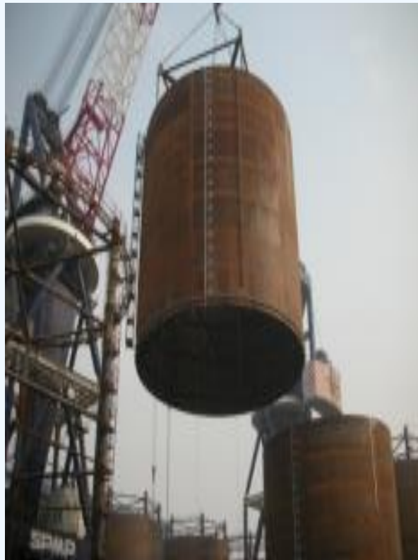
钢圆筒在上海振华重工制作
