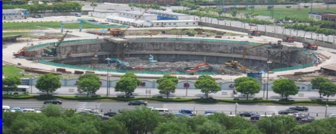
上海环球金融中心基坑支护工程
