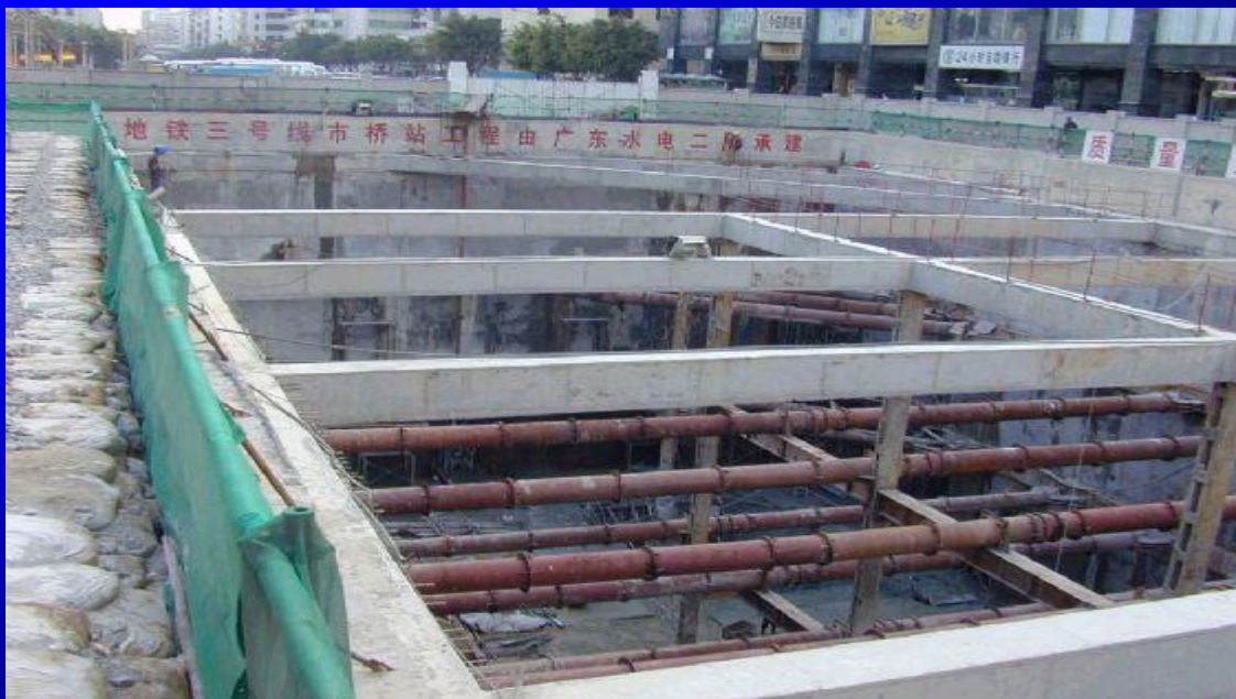
广州地铁（市桥站）基坑
