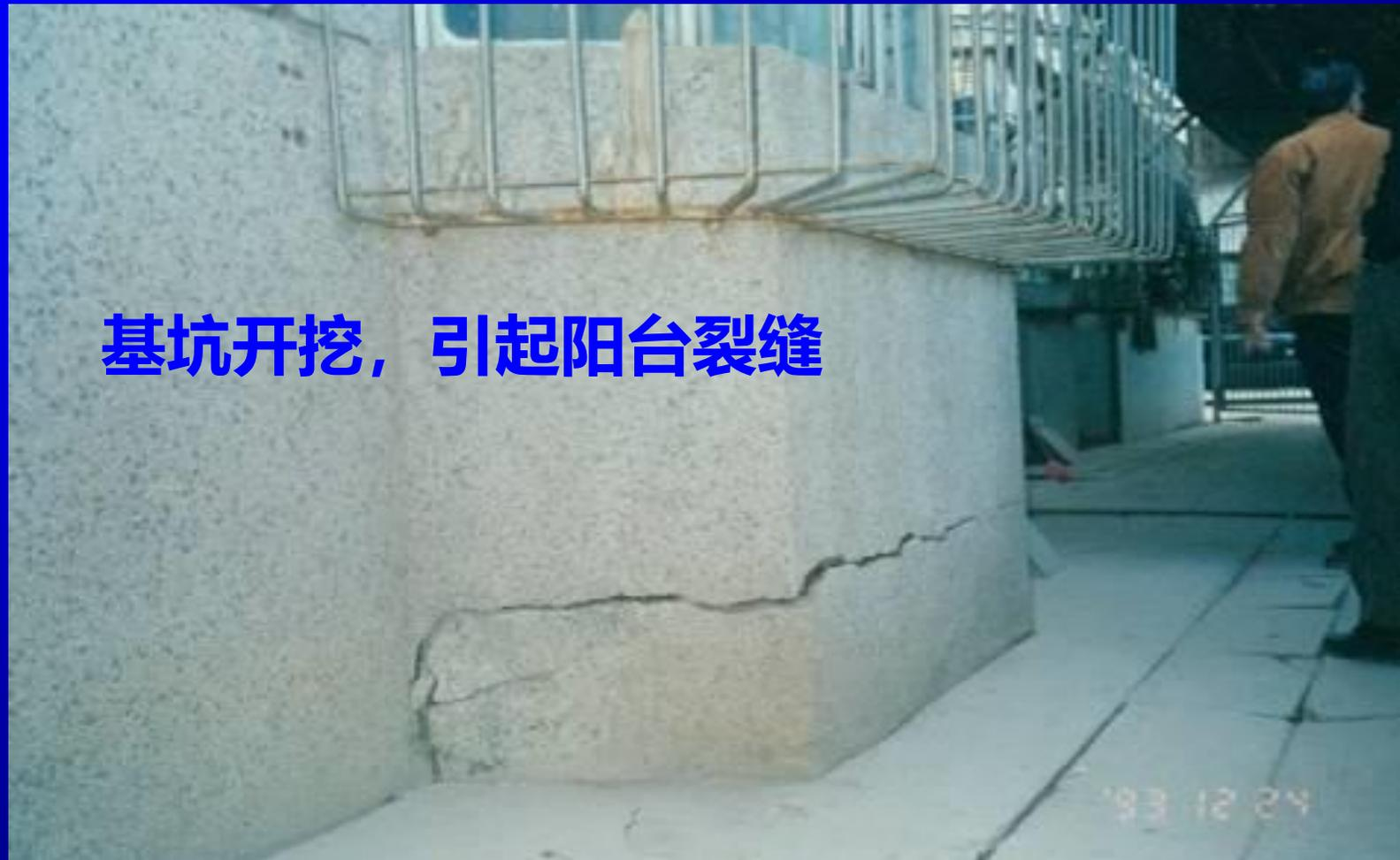
基坑开挖，引起阳台裂缝
