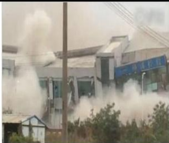
实拍深圳山体滑坡致厂房倒塌瞬间
