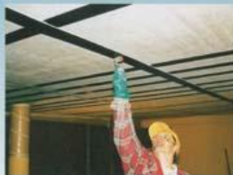
加固钢筋混凝土楼板使用Sika®CarboDur®板系列 (Sikadur-30粘剂及Sika®CarboDur®板)
